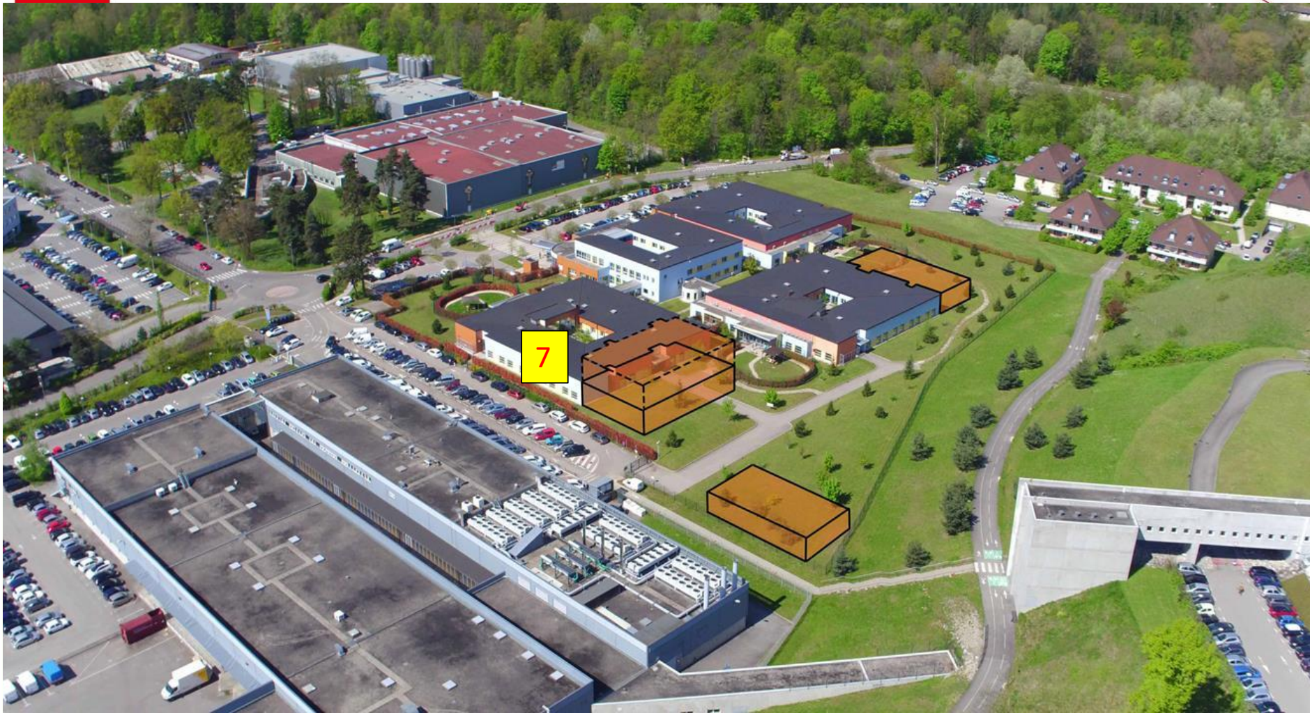
7- 8: Extension/restructuration bâtiment psychiatrie
